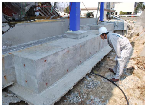
SB基礎の状況
