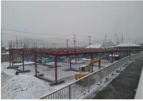
SB固定柱脚工法鉄骨建て方時
